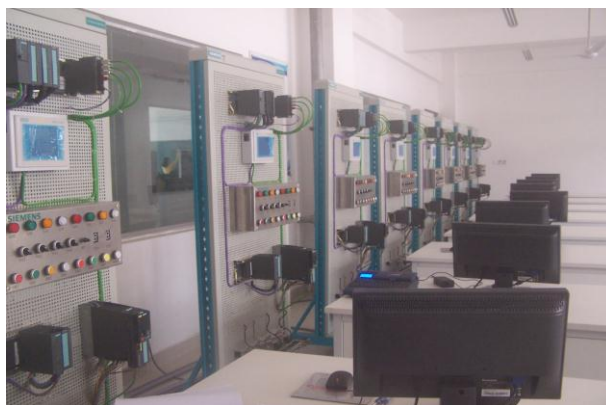
S7-300 为核心的工业网络控制实训室
